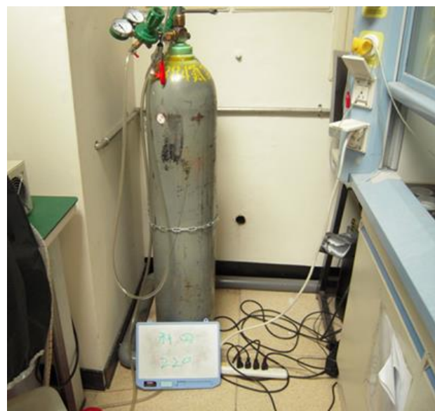
有使用鐵鍊網綁， 但無法達到有效固定功能
