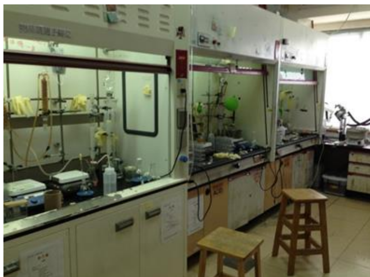
使用排煙櫃時，門開至正確之操作位置
