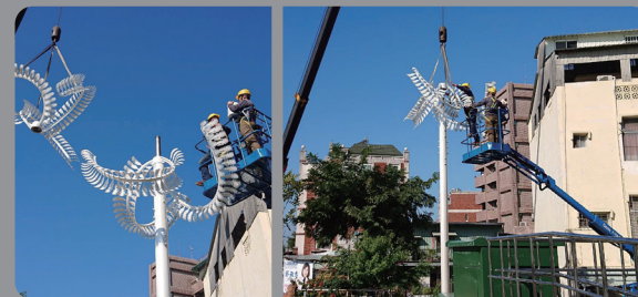
現場安裝設置
