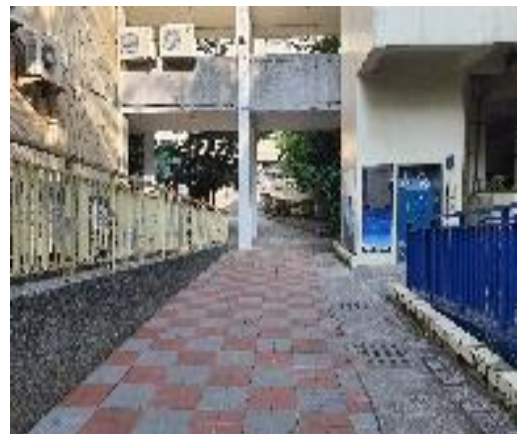
圖 4 中型以上施工機具無法進出及施工(無施工空間)
