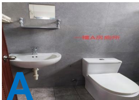
一樓 A 房廁所
